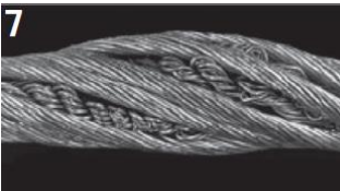
7 Kvůli kroucení lana o kladkostroj se prameny v jádře lana přebytečně prodloužily. Taková poškození se mnohokrát nachází na koncích pohybu lana, které je vedeno přes kladkostoje nebo bubny.
