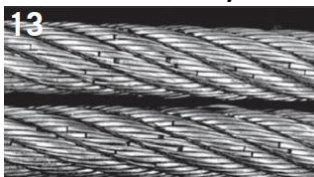
13 Zlámání drátů na ocelových laněch se zavřenými prameny způsobené vyčerpáním.
