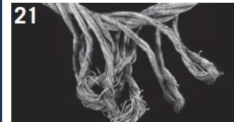
21 Toto lano se zcela rozvinulo. Vnější prameny jsou pro ocelové lano příliš dlouhé. Tam, kde kladkostroj tlačil na přebytečné prodloužení, stojí prameny zpříma.
